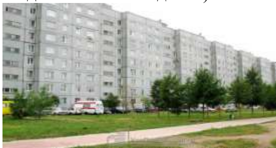
Фото 1 (панельная девятиэтажное здание)
